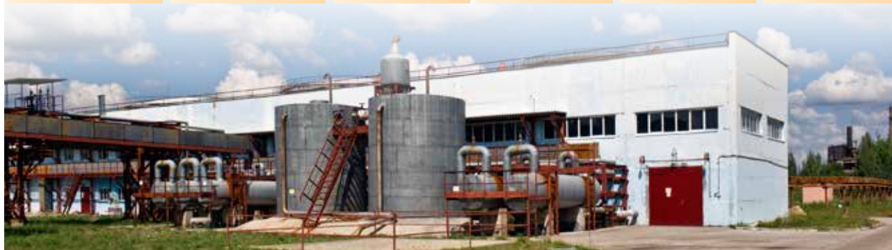
Котельный цех. Насосная станция мазутного хозяйства
