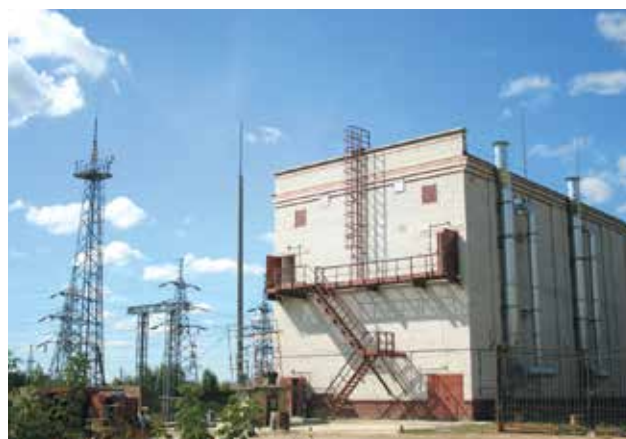
Закрытое распределительное устройство 110 кВ
