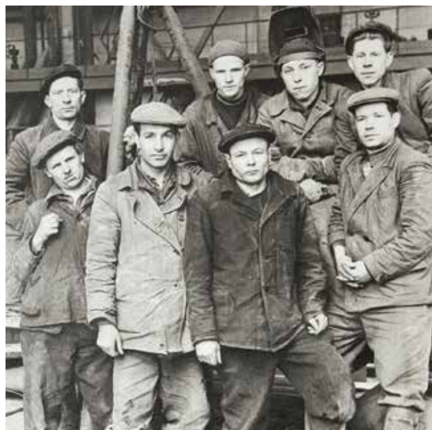
Передовая бригада Рязанского отделения треста «Центрэнергомонтж» Четверика Л.И. на монтаже котла № 1. 1959 год
