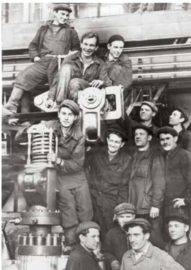
Бригада монтажников Рязанского отделения треста «Центрэнергомонтаж» на монтаже паровой турбины № 1. 1959 год
