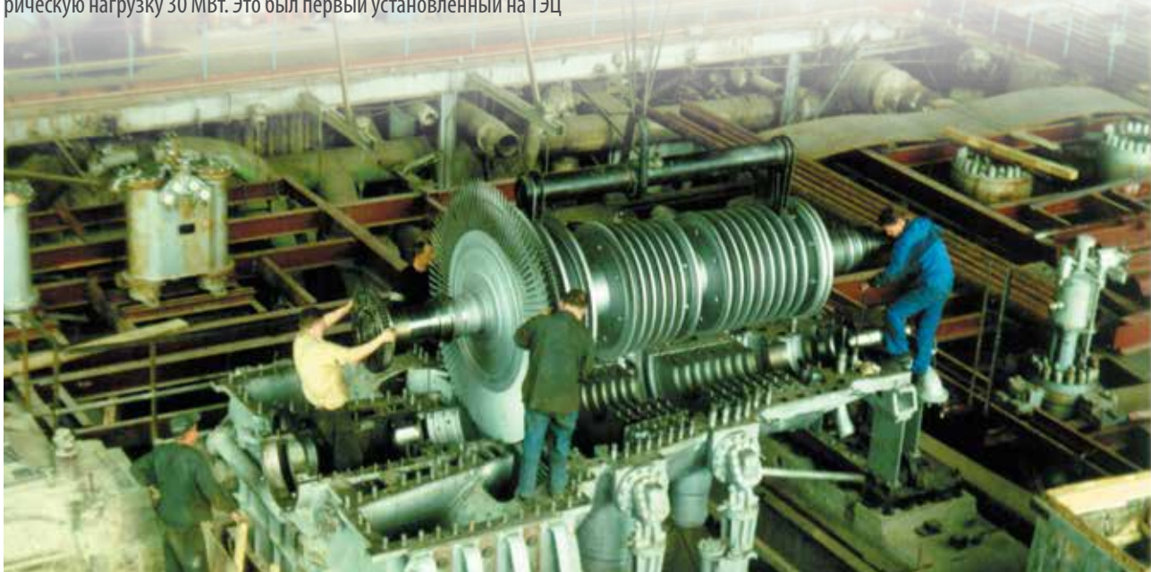
Монтаж нового турбоагрегата № 1
