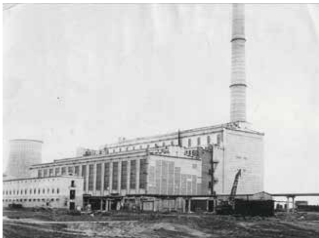
Строительство Ново-Рязанской ТЭЦ. 1958 год.
