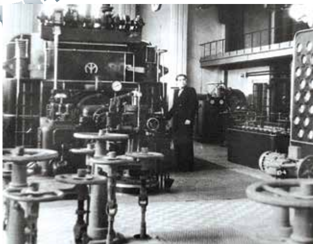
Турбина № 1 типа ВПТ-25 мощностью 25 мегаватт. У синхронизатора - машинист турбины Демин Н.В. Сентябрь 1959 года
