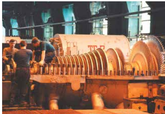
Монтаж новой турбины №6
