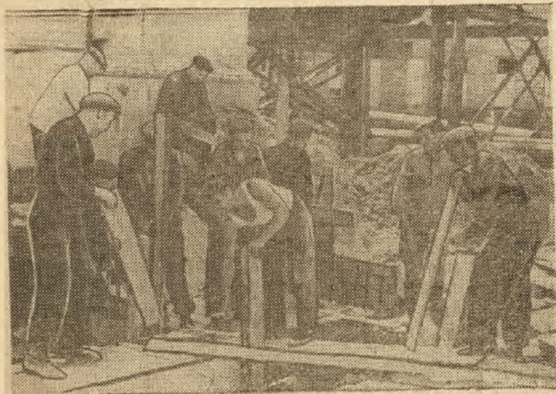
На снимке: комплексная комсомольско-молодежная бригада СУ-3 В. Луканькина, борющаяся за звание бригады коммунистического труда, выполняющая последние работы на технологическом тоннеле участка «А».
