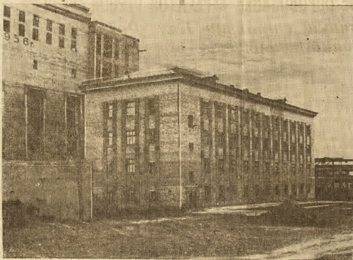
На снимке: административно-хозяйственное здание дирекции Ново-Рязанской ТЭЦ. Сейчас отделочные работы в здании закончены.
